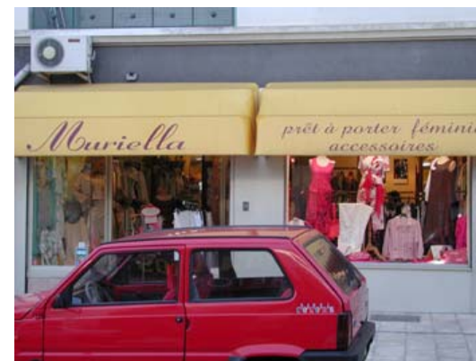
Caisson de climatisation en façade : Trouver des solutions pour les masquer et/ou les intégrer à la devanture
