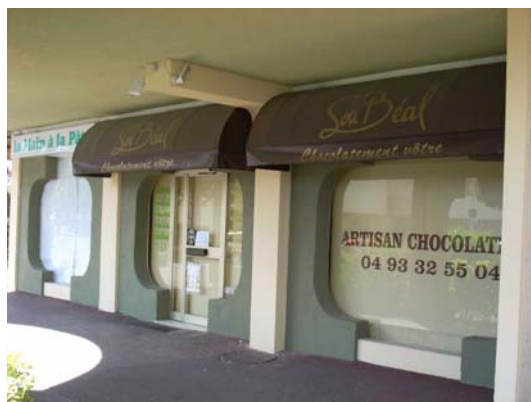
Stores à éviter sous les galeries : La fonction du store est de protéger du soleil ou de la pluie ⇒ inutile sous une galerie couverte
