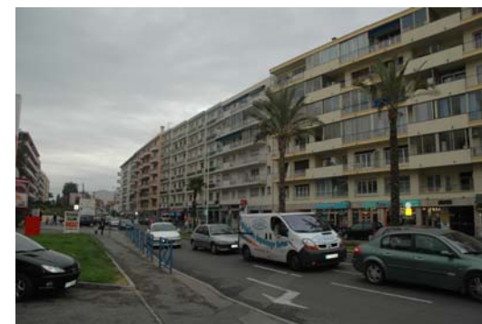
Avenue de Nice - Immeubles récents Linéaires de balcons marquant les horizontales
