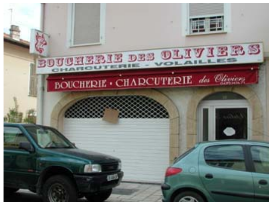
Non respect de l'architecture de la façade
