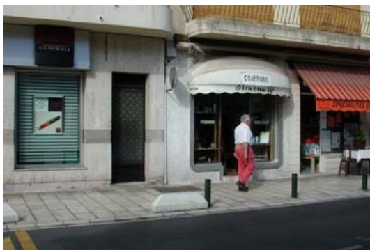
Store en corbeille à éviter : il masque l'architecture de la façade
