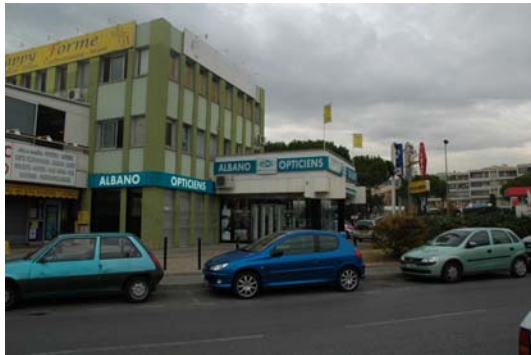
Pas d'alignement remarquable des constructions
