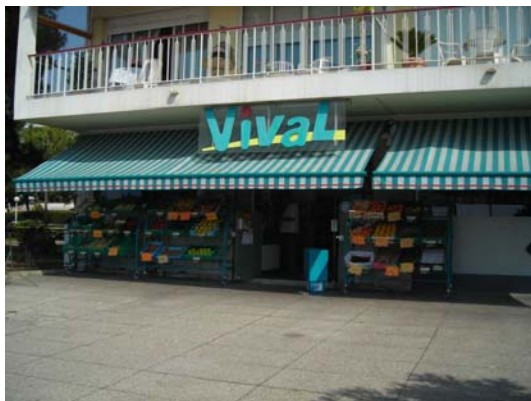
Linéaire de bannes rayées à éviter : elles masquent complètement l'architecture de la façade Enseigne surdimensionnée non inscrite dans l'emprise de la devanture
