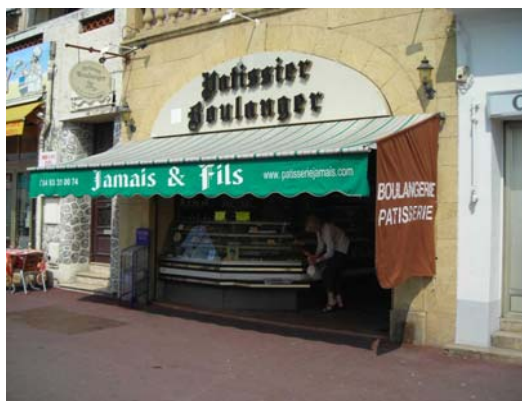
Non respect de l'architecture de la façade La banne ne doit pas dépasser la largeur de l'arcade
